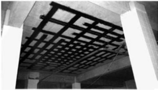
Reforço de laje de instalação Industrial para permitir a instalação de novos equipamentos
