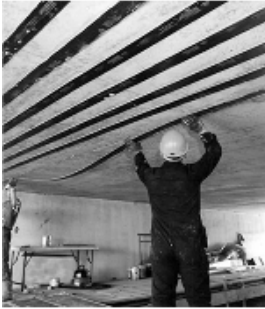
Reforço com fibra de carbono
