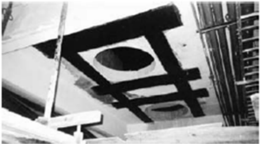
Reforço para permitir a execução de furos para instalação de novos equipamentos
